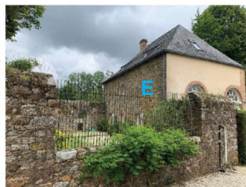
Vue de l'orangerie - façade nord
