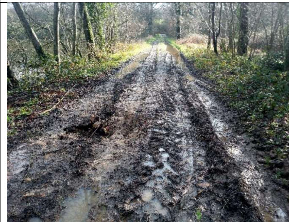
Chemin situé entre les deux étangs
