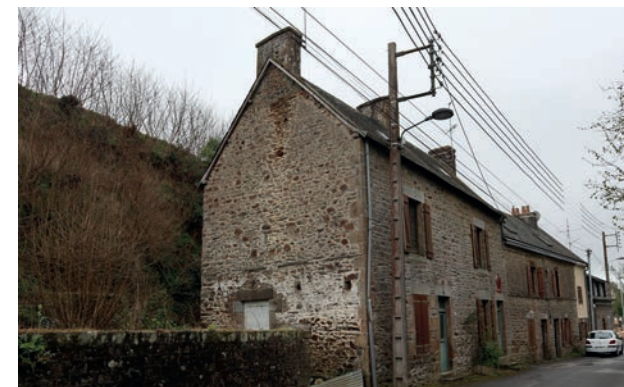
Rue du Moulin à Tan
