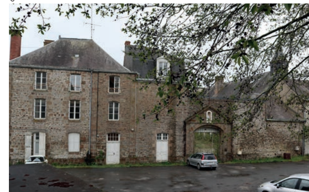
Ancien Couvent, route de l'Hôpital
