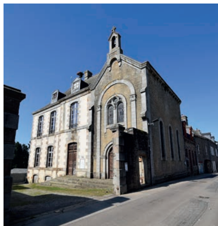
— Hôtel de la Miséricorde, façade est (à gauche) et chapelle (à droite) Cliché de C. Chauveau, Hadès, 2022
