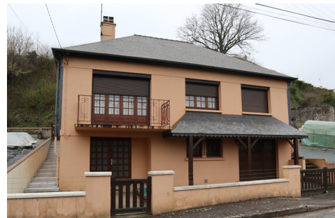
Rue du Moulin à Tan
