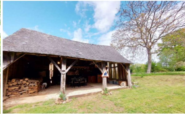
Ancien abri à bois existant ( Bât D ) :
