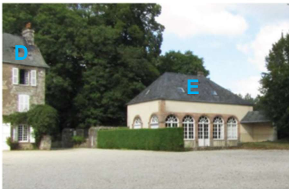
Vue de l'orangerie - façade sud
