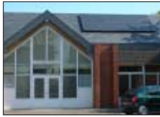
La commune couvre les besoins en électricité de la salle et vend le surplus à E.D.F.
