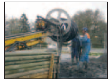
Le forage des puits
